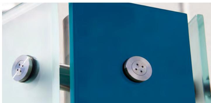
**Option 3:** Verbinder mit Flachsenkkopf und konischer Glas- bohrung statt Zylinderkopf
